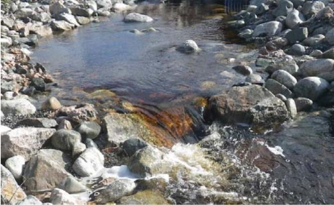
**Photo 3.41 Aménagement réalisé en 2014 - Frayère d'omble de fontaine en amont d'un seuil en enrochement (septembre 2015)**
