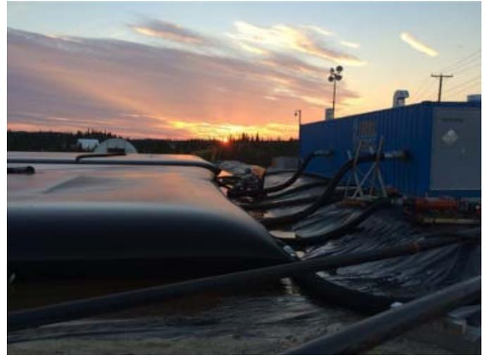
**Photo 3.22 Géotubes servant à récupérer les boues de traitement**
