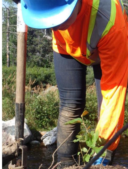
**Photo 3.47** Technique de plantation utilisée pour accélérer la repousse végétale en rive de cours d'eau (août 2016)
