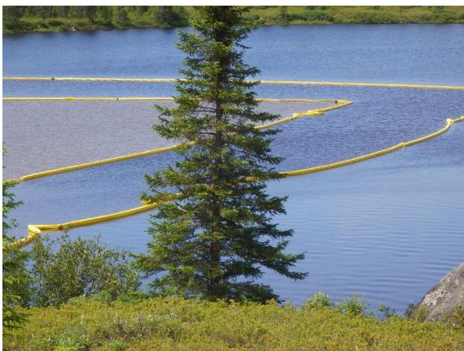
**Photo 3.1** Double rideau de turbidité en guise de mesure d'atténuation pour des travaux dans un plan d'eau
