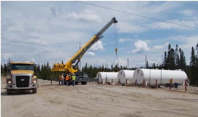
**Photo 6.1** Démantèlement des installations pétrolières du campement d'exploration
