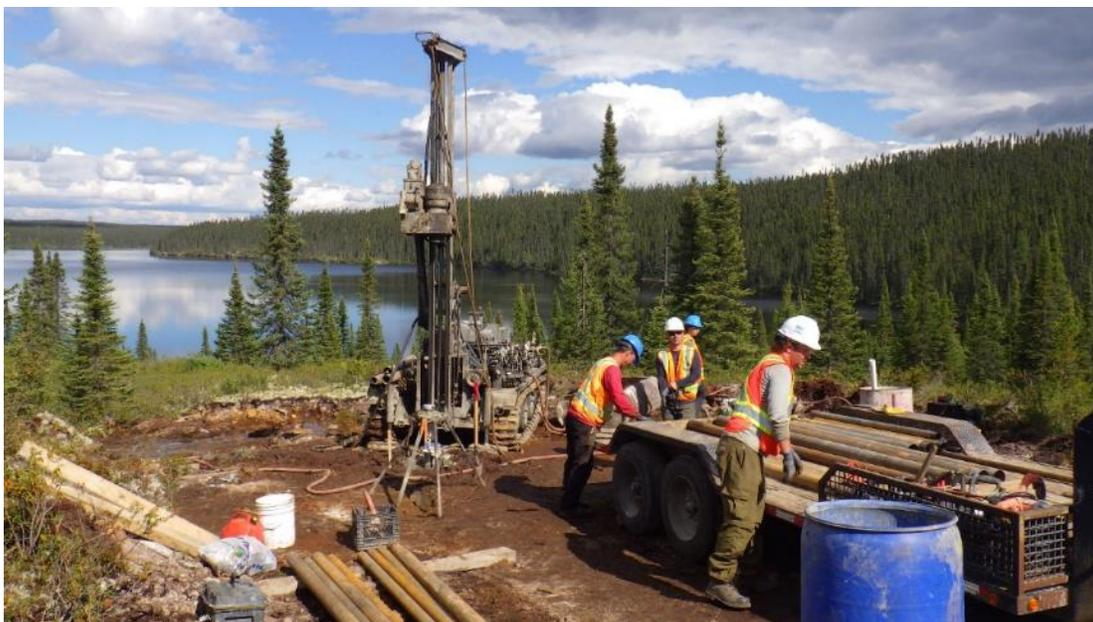
**Photo 3.18 Forage d'un puits d'observation autour de l'aire d'accumulation de la kimberlite usinée en 2016**
