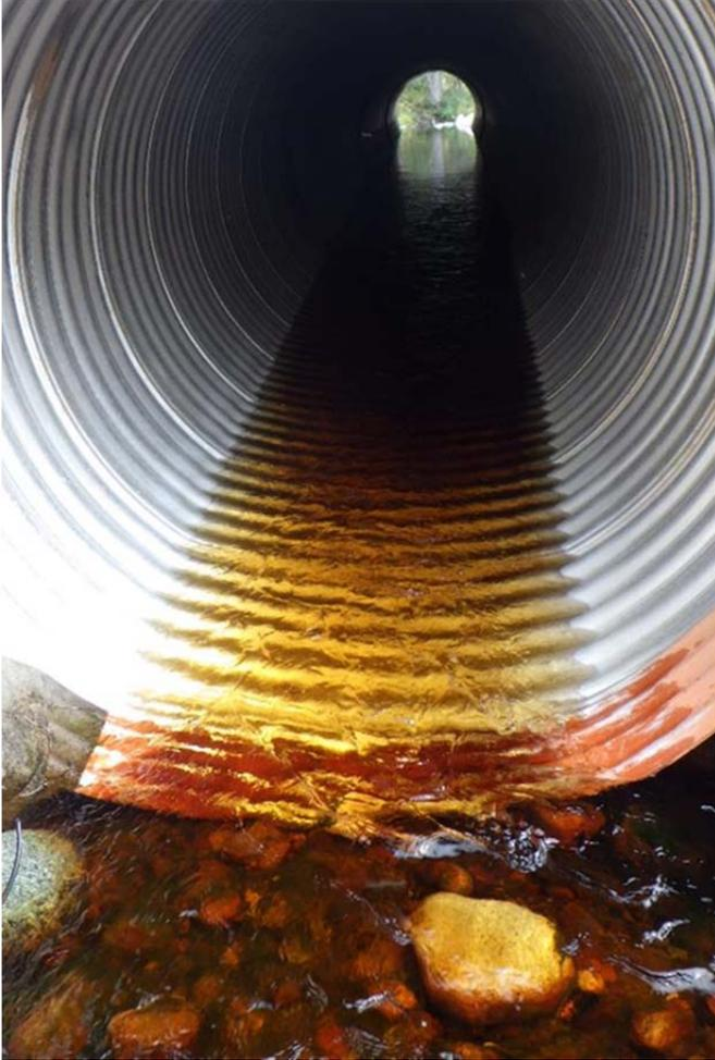
**Photo 3.39** Section uniforme en amont du ponceau qui assure le libre passage de l'omble de fontaine
