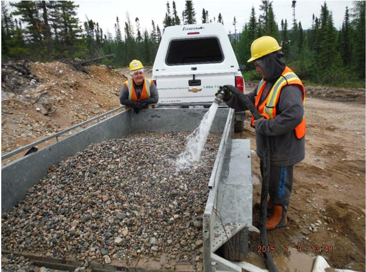
Photo 4.2 Nettoyage du gravier pour l'aménagement de frayères d'omble de fontaine (été 2015)
