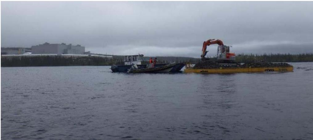
**Photo 3.36** Pelle excavatrice sur une barge permettant d'apporter et de placer la pierre pour l'agrandissement de la frayère à touladi (août 2016)
