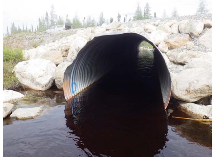
**Photo 3.40** Section uniforme en amont du ponceau qui assure le libre passage des espèces de poisson présentes dans le cours d'eau
