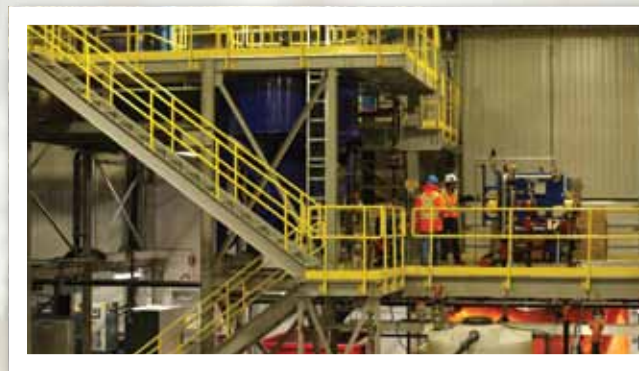
Avril 2016 - Mine water treatment plant
