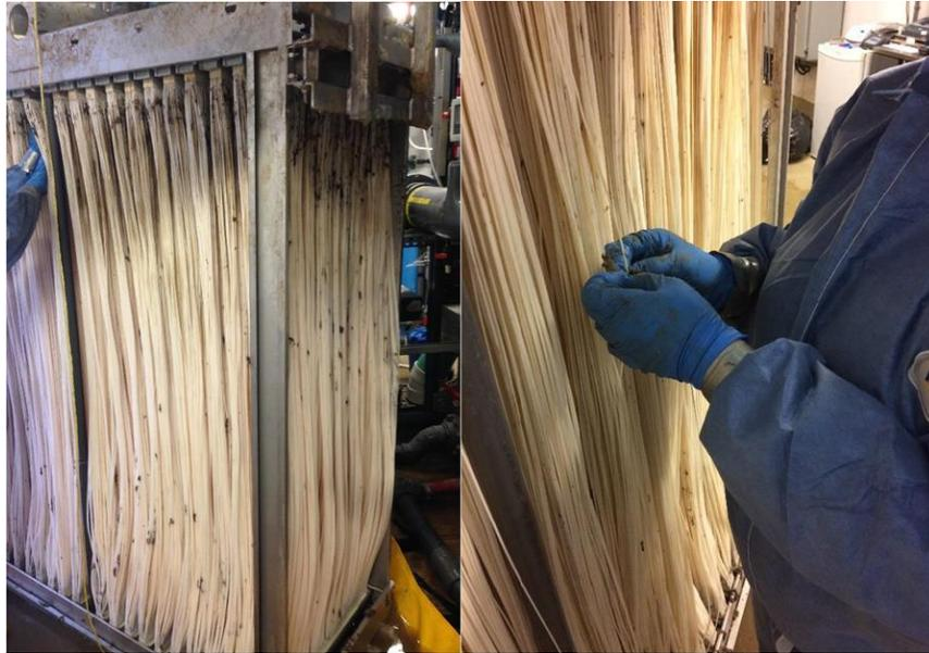
**Photo 3.45** Inspection et nettoyage d'une unité de filtration membranaire
