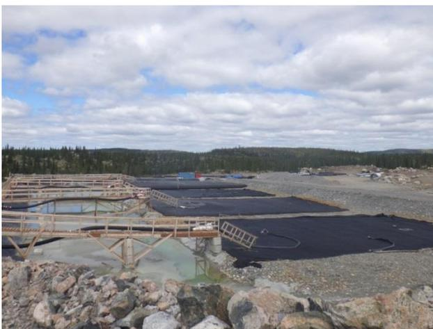
**Photo 3.43 Usine de traitement modulaire avec sacs filtrants nommés Geotube®**
