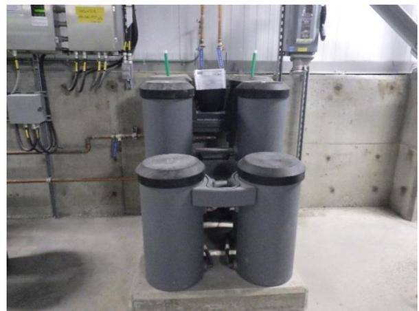
**Photo 3.46** Séparateur des condensats de la remontée d'air frais (FAR)
