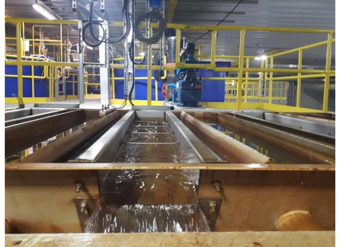
Photo 3.41 Aspect visuel de l'eau traitée à la sortie des décanteurs lamellaires
